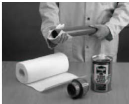
obrázek 5: čištění trubky a nátrubku
